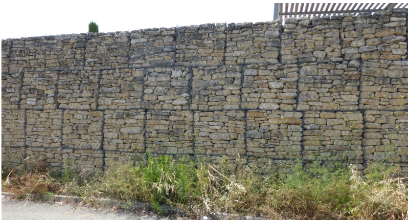
Mur de gabion: rappel de la terrasse du Jardin Romain de Caumont.
